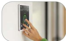
**Intégration de la gestion de la qualité de l'air intérieur** à un système de gestion du bâtiment (GTB) via Modbus RTU ou API Cloud.
